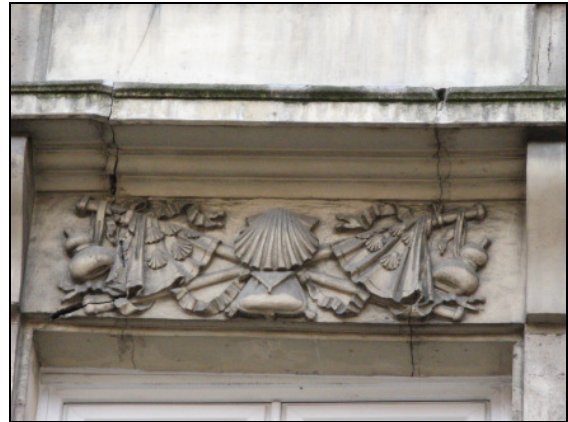
Fenstersturz am ehemaligen Pilgerhospital St. Jacques
