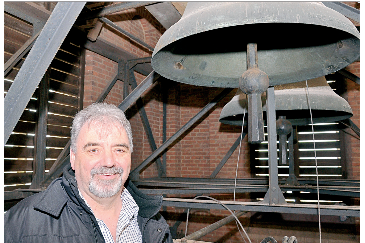
Eugen Cilleßen vom Förderkreis Glocke freut sich über die gelungene Spendensammlung. Im Nordturm der Stiftskirche machte er sich ein eigenes Bild von den Arbeiten. Fotos: Breuer
